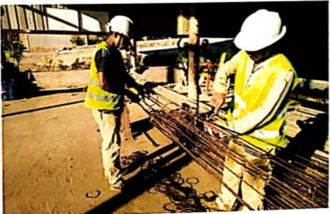
၇.၅ မီလီမီတာ လိုအပ်သည့် အရွယ်အစားဖြတ်တောက်၍ Inner Circular Ring ပြုလုပ်ခြင်းနှင့် ၇.၅ မီလီမီတာ Steel သံချောင်းများ ကို လိုအပ်သည့် အတိုင်းအတာဖြတ်တောက်၍ ကျောရိုး သံချောင်း (Main Bar) ပြုလုပ်ခြင်း
