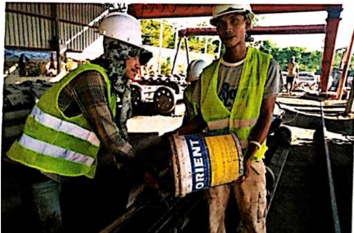
ပြုလုပ်ပြီးသော သံချည်သံကွေး (Steel Structure) များကို (Mild Steel Mould) သံမဏိမို့ ထည့်သွင်းပြီး လိုအပ်သော (Tension) ရရန် (Pre Stressed) ပြုလုပ်ခြင်းနှင့် ဘီလပ်မြေ၊ သဲ၊ ကျောက်တို့ကို (Mixed Ratio) အတိုင်းရောစပ်၍ တိုင်ပုံ (Pole) ပြုလုပ်ခြင်း
