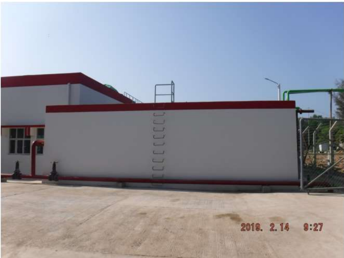
(d) Raw Water Reservoir
