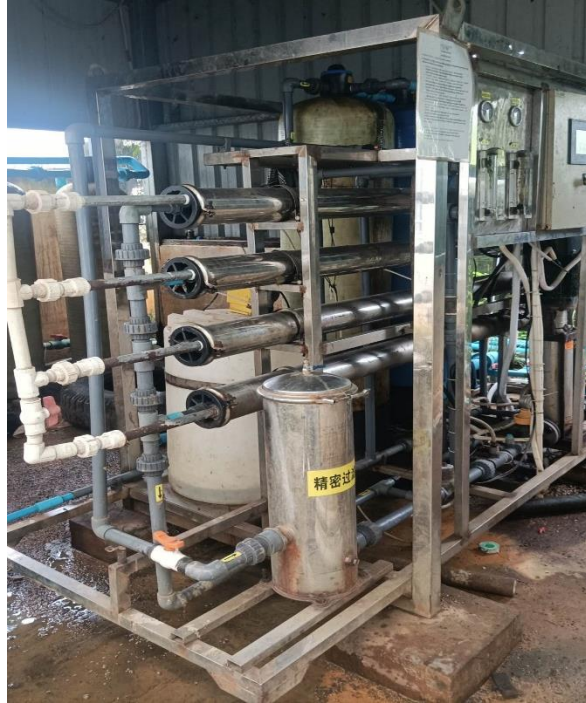
ပုံ(8) လုပ်သားများ သောက်သုံးရေအတွက် သောက်သုံးရေသန့်စင်ရေးစနစ်ကို စက်ရုံ၏တာဝန်ရှိသူမှ တပ်ဆင်ထားခြင်း
