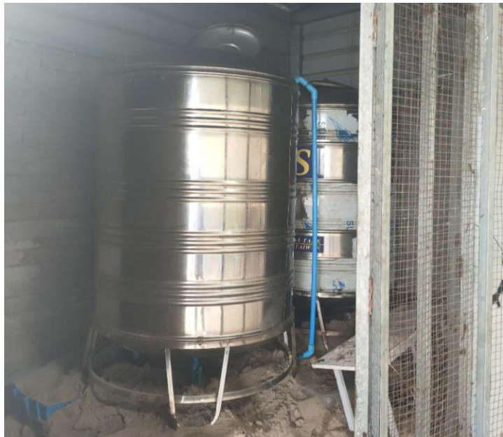
ပုံ(7) အဝီစိတွင်းရေအား အဝီစိတွင်းရေအားကွန်ကရစ်ရေကန်နှင့် စတီးတိုင်ကီဖြင့်လည်းအရန် သိုလှောင်ထားပုံ
