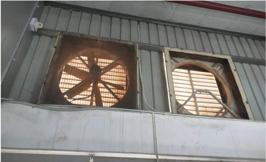
ပုံ(13) လုပ်ငန်းခွင်၏လေအရည်အသွေးနုကောင်းမွန်ရန် နှင့် အပူချိန်ထိန်းညှိရန်လေထုတ်ပန်ကာများတပ်ဆင်ထားခြင်း
