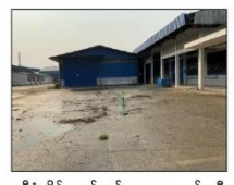
စီမံကိန်းလည်ပတ်ရာ အဆောက်အဦ
