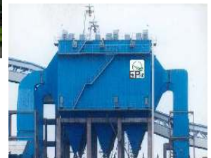
Electrostatic Precipitator(EP)- ပြာမှုန် ဖမ်းစက်
