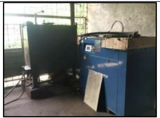
မီးစက် Transformer
