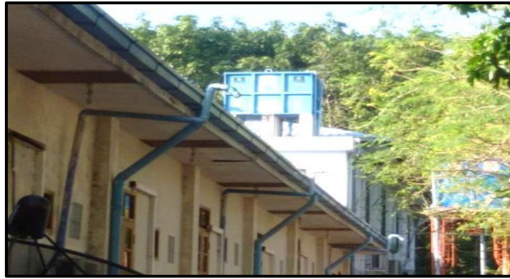
ပုံ(၄-၇၆) overhead tank တိုင်ကီပုံ။
