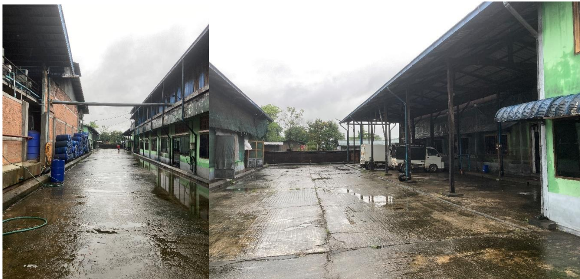
စက်မှုလမ်းသွယ်(၃)လမ်းဘက်ရှိ ဝင်ပေါက်မှ မြင်တွေ့ရမည့် မြင်ကွင်းပုံနှင့် ကားရပ်နားနေရာ ပုံ(၄) Top One အရက်ချက်စက်ရုံ၏ အဆောက်အဦများကို မြင်တွေ့ရပုံ
