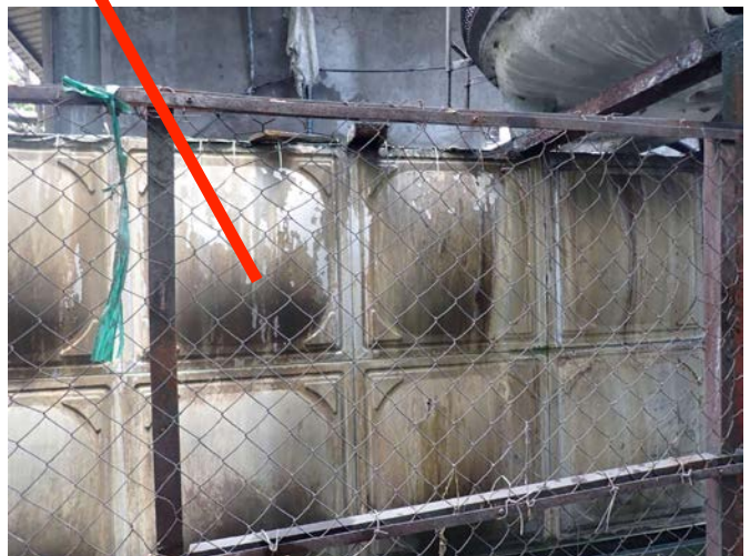
ပုံ (၂.၁၄) (ခ) အမှုန်အမွှားနှင့် အခိုးအငွေ့စစ် ကိရိယာမှ ထွက်ရှိလာသော ရေများဝင်ရောက်ရာ တိုင်ကီ
