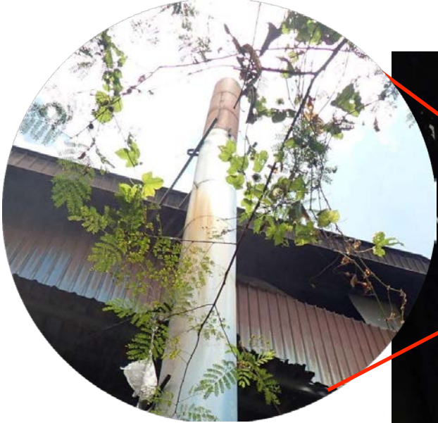
ပုံ (၂.၁၄) (က) အမှုန်အမွှားနှင့် အခိုးအငွေ့စစ် ကိရိယာနှင့် အမြင့် ၇၂ ပေ ရှိသော မီးခိုးခေါင်းတိုင်
