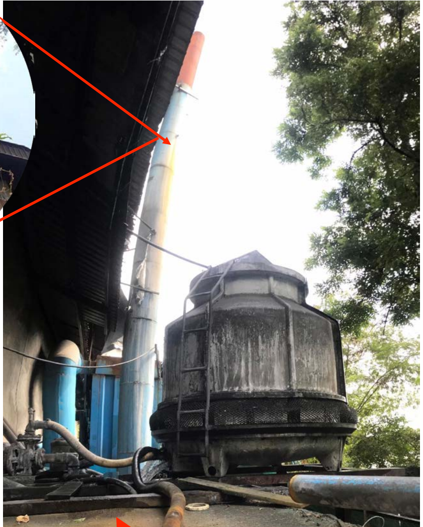
ပုံ (၂.၁၄) (က) အမှုန်အမွှားနှင့် အခိုးအငွေ့စစ် ကိရိယာနှင့် အမြင့် ၇၂ ပေ ရှိသော မီးခိုးခေါင်းတိုင်
