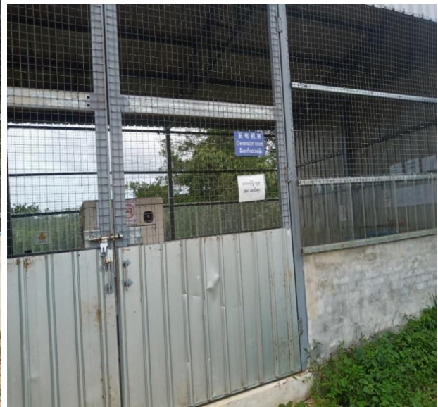
မီးစက်အဆောက်အဦ
