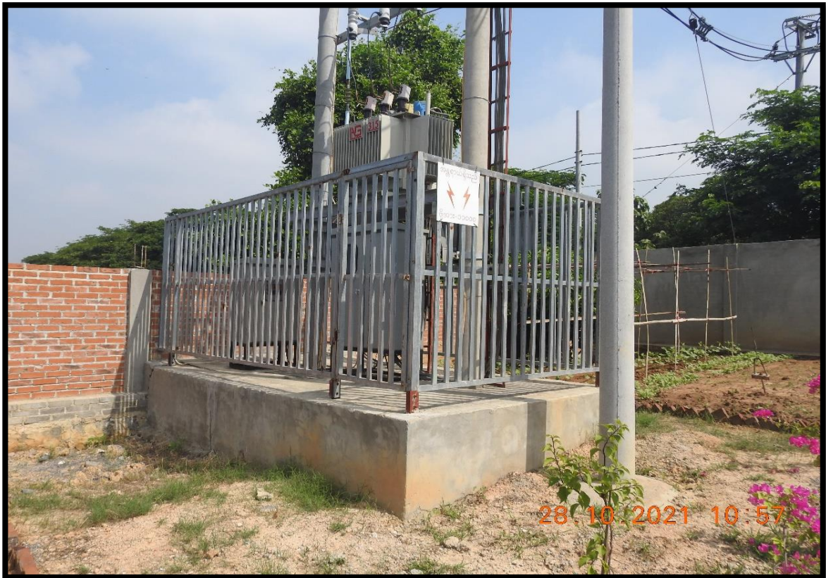
စက်ရုံရှိ ကိုယ်ပိုင်ဓာတ်အားခွဲရုံ (315 KVA)
