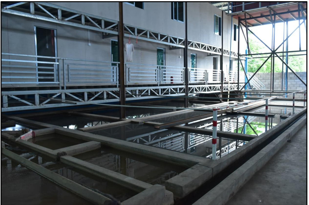
ပုံ(၇) လုပ်ငန်းသုံးရေအနည်ထိုင်ကန်များ (Settling Pond)
