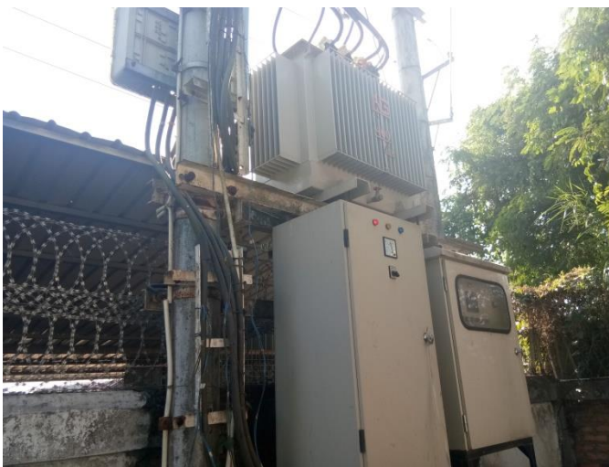
Transformer (400 kVA)
