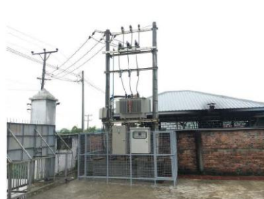
315kVA Transformer နှင့်အသုံးမပြုသည့် 400 KVA Transformer
