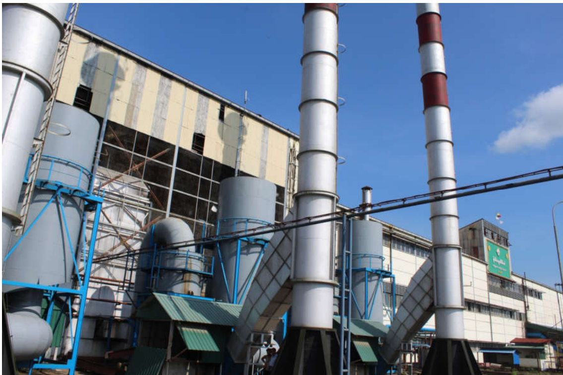
Dust Collector (၃)လုံး နှင့် မီးရိုးခေါင်းတိုင် (၃)လုံးပုံ
