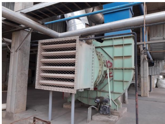
i) Air Fan with Silencer
