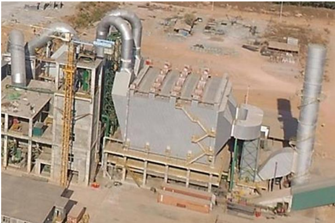
ပုံ (၂၄): MCL ဘိလပ်ချေမော်ကူဖြင့် တစ်ခုသော Electrostatic Precipitator (EP)
