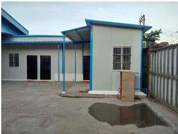
ရုံးအဆောက်အဦ
