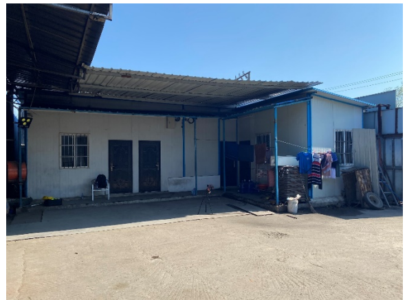
ရုံးအဆောက်အဦ
