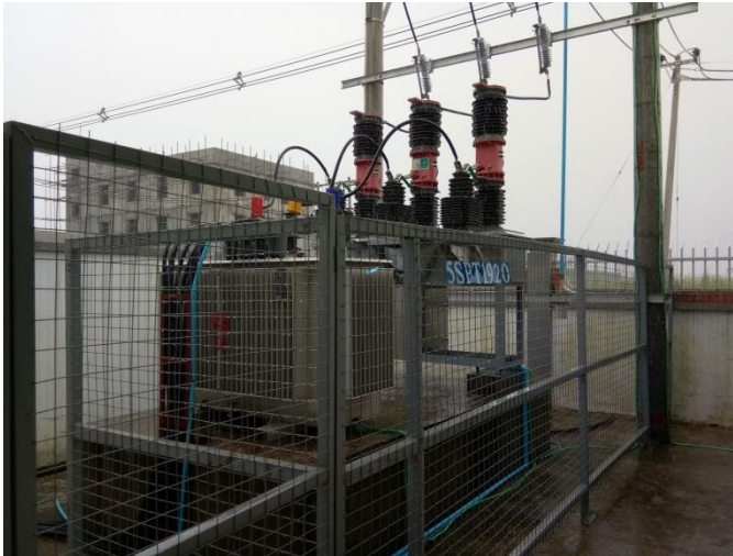
Transformer (500 kVA)
